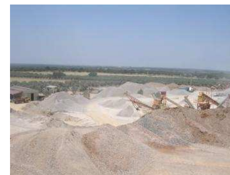
Figura 2: Vista para a Central de Britagem.
